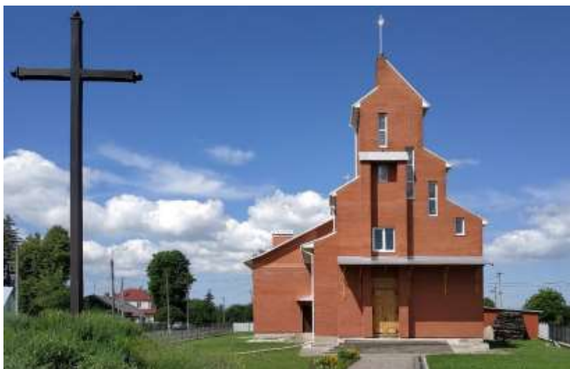
З кінця 2000 –х по 2014 р. тривало будівництво мурованого костелу і плебанії. В 2018 році відбулося освячення костелу Святої Трійці
