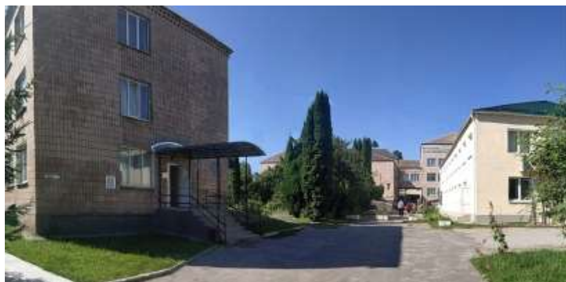
Центральна районна лікарня
