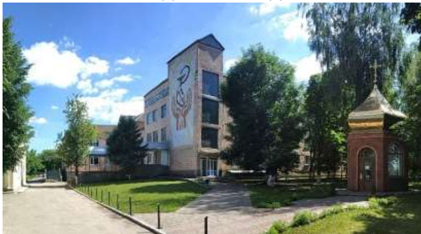
Центральна районна лікарня
